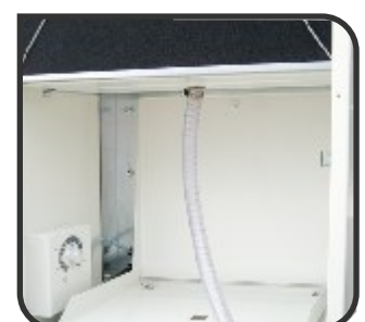
Toma de conexión para acoplar una manguera de desagüe y enviar el agua condensada directa a un sumidero.
