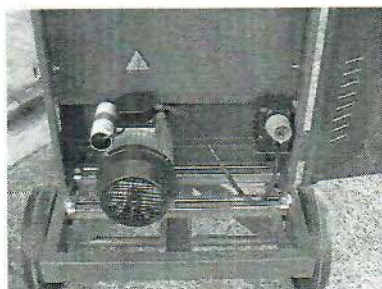
Fig. 2.2. Montaje del motor eléctrico.
